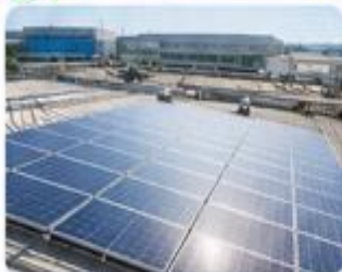
ติดตั้งระบบ Solar Rooftop โดย B.Grimm
